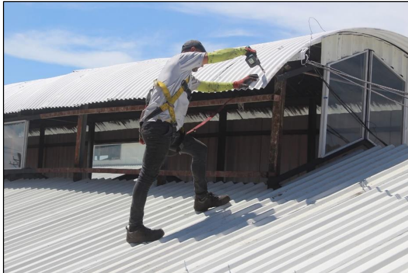
Imagen 11: arreglos realizados en los techos del Mercado Municipal de Cartago.
