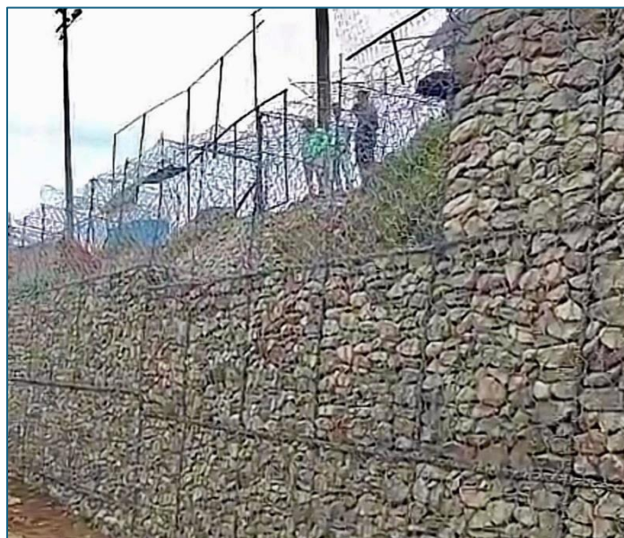
Imagen 20: labores de construcción de muros de contención en la plaza de deportes de la comunidad de Quircot, distrito de San Nicolás.
