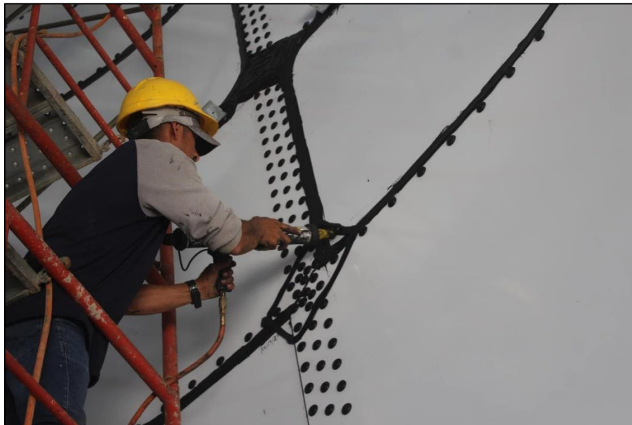
Imagen 16: construcción del tanque de almacenamiento presentado anteriormente.
