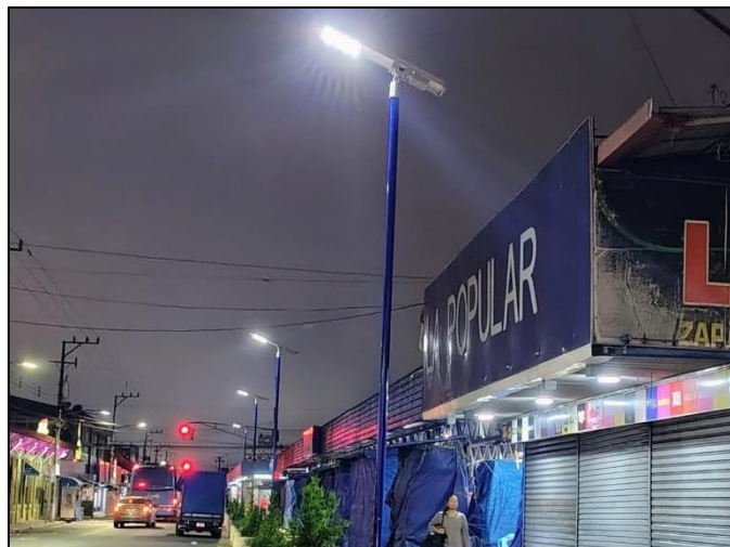
Imagen 12: lámparas solares instaladas en el perímetro del Mercado Municipal de Cartago.
