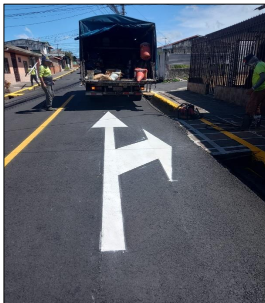
Demarcación horizontal camino 30118400
