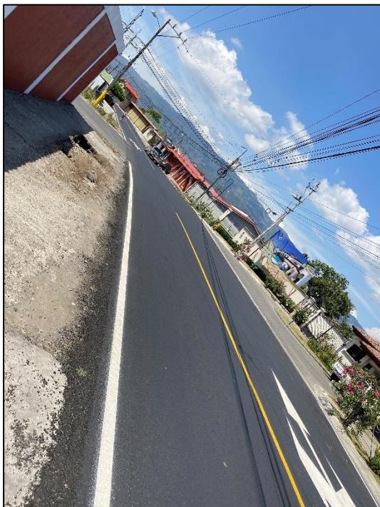
Demarcación horizontal camino 30141800
