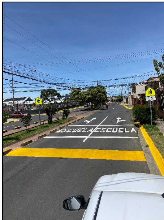
Demarcación horizontal camino 30106200
