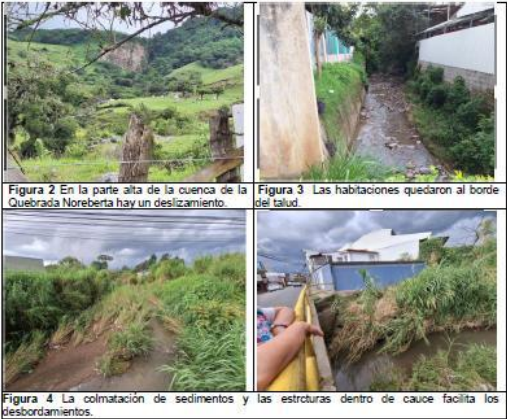
Figura 4 La colmatación de sedimentos y las estructuras dentro de cauce facilita los desbordamientos.
