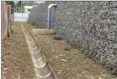
Fotografía 3 Canal inferior base del muro y estructura del mismo.
