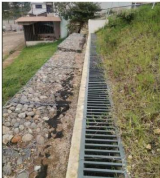
Fotografía 2 Canal Pluvial Superior
