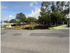
Fotografía No.1: Vista general, km 1+785 LI
