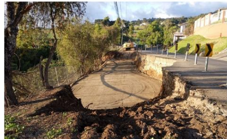
Fotografía No.3 Intervención hundimiento Ruta Nacional No.218
