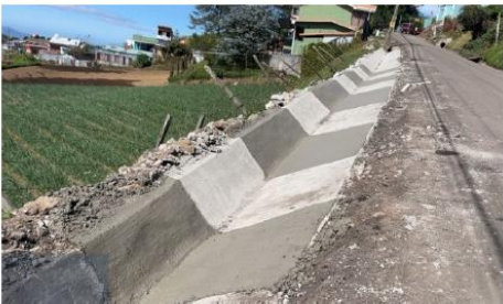
Fotografía No.1 Construcción de cunetas Ruta Nacional No.401
