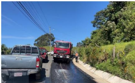
Fotografía No.2 Carpeta asfáltica Ruta Nacional No.401
