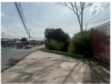
Fotografía No.3: Vista general km 1+820 LD
