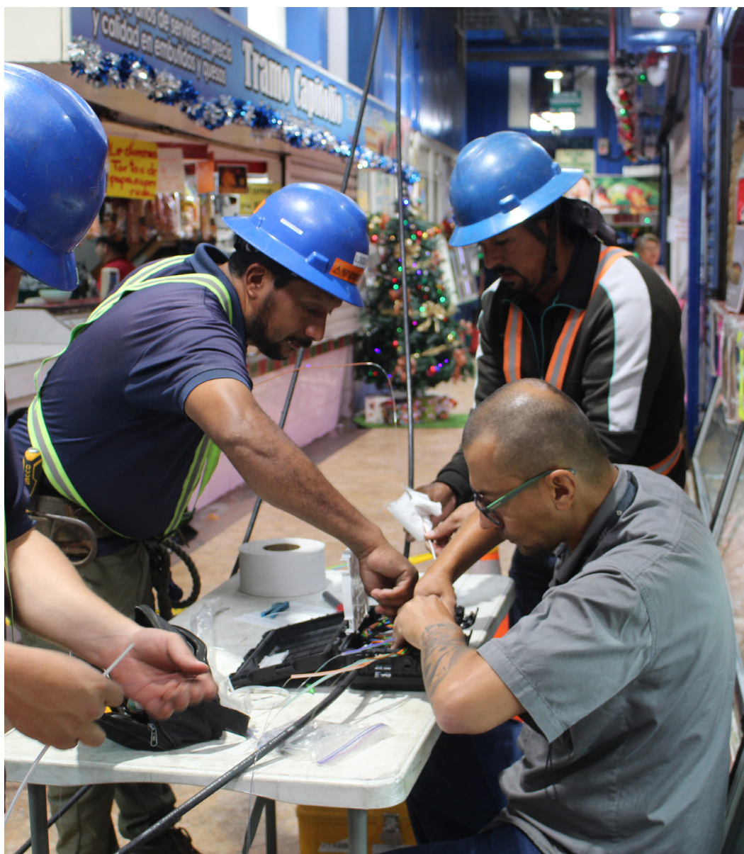
La administración del Mercado ejecuta el proyecto de instalación de red de fibra óptica en sus instalaciones.
