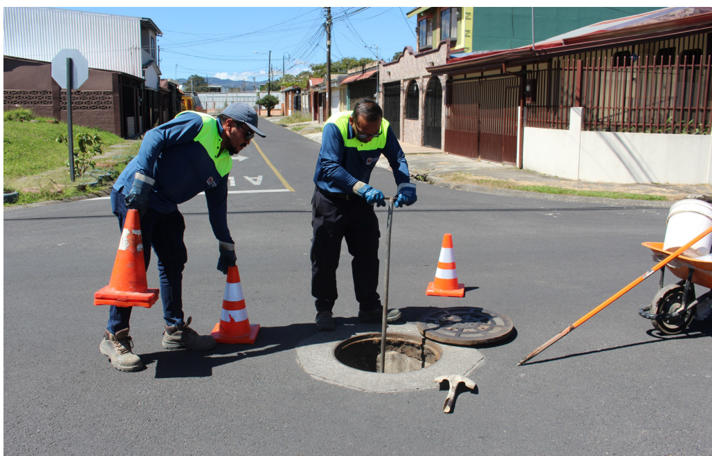
Cuadrillas de Alcantarillado Sanitario intervienen los pozos de inspección en vías públicas para garantizar el flujo óptimo de las aguas residuales.
