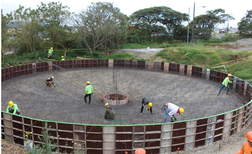
Proceso de colocación de armadura de la losa de concreto del tanque sedimentador.
