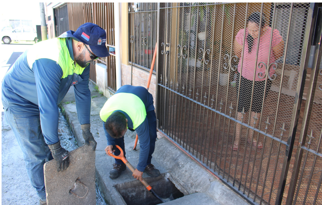
Personal operativo realiza la limpieza y despeje de cajas de registro domiciliarias como parte del plan preventivo en los distritos del cantón.
