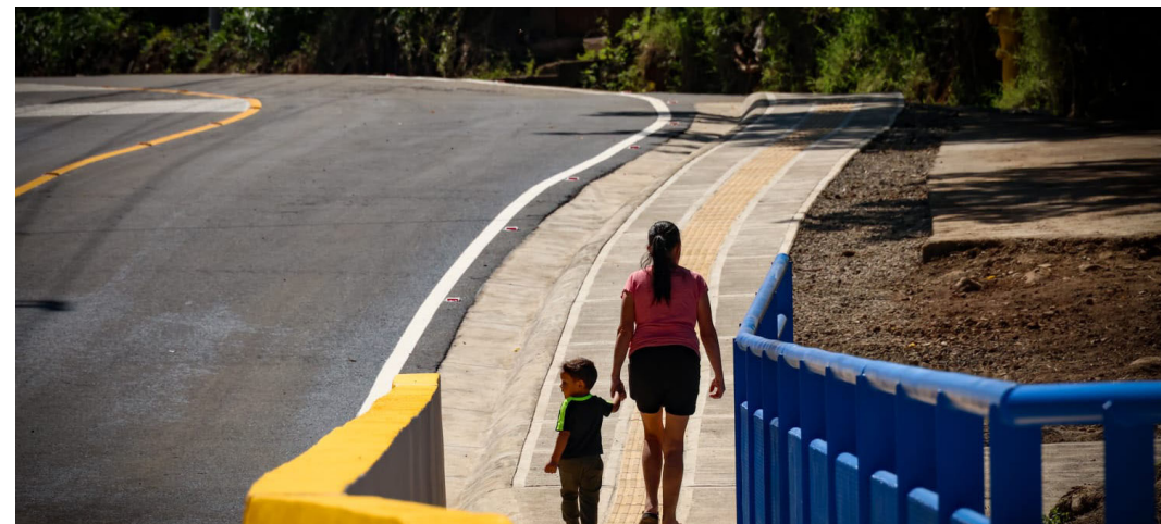
El proyecto requirió una inversión cercana a los ₡270 millones para garantizar su alta resistencia y durabilidad.
