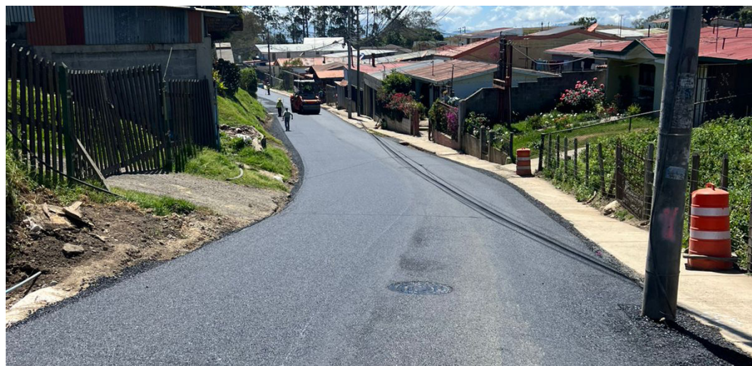
Asfaltado en Llano Grande, tras cambio de tuberías para evitar inundaciones.
