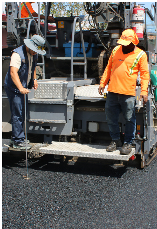
Realizando el monitoreo del espesor de la carpeta asfáltica
