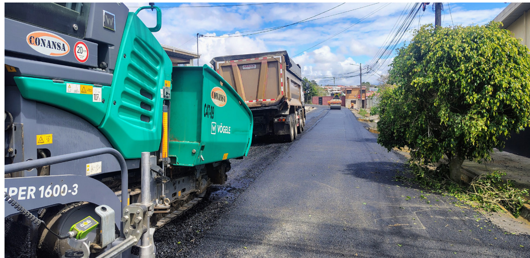
Trabajos al Oeste de la Iglesia Maná, distrito de Oriente.
